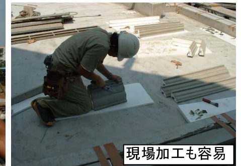
モール間シーリング
